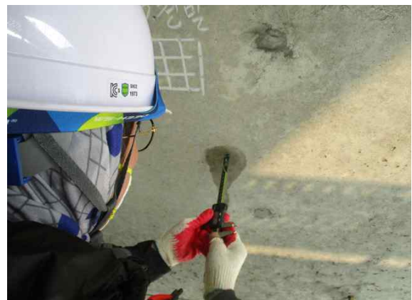
b. 탄산화 깊이 측정
